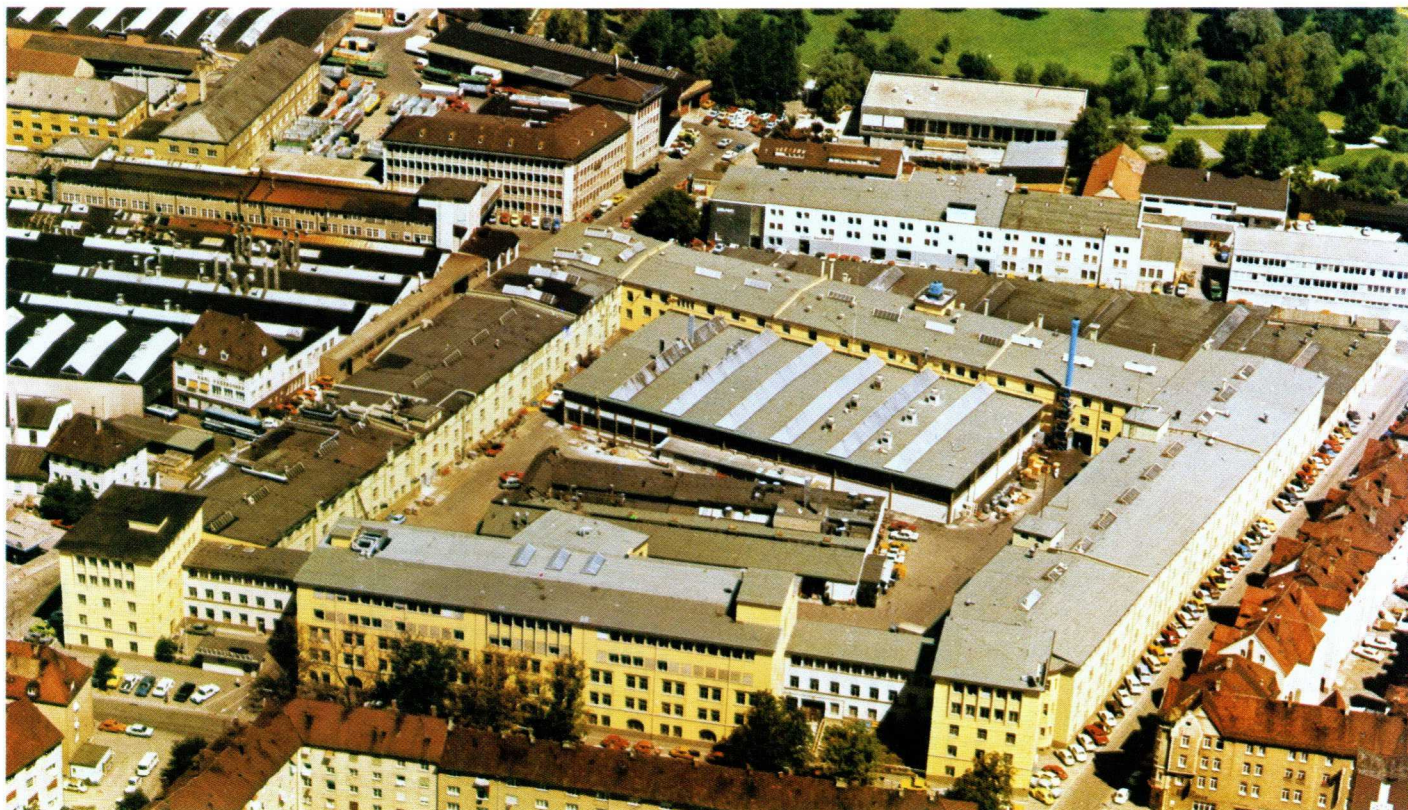
Röhrenwerk · Tube factory Ulm, Söflinger Strasse
